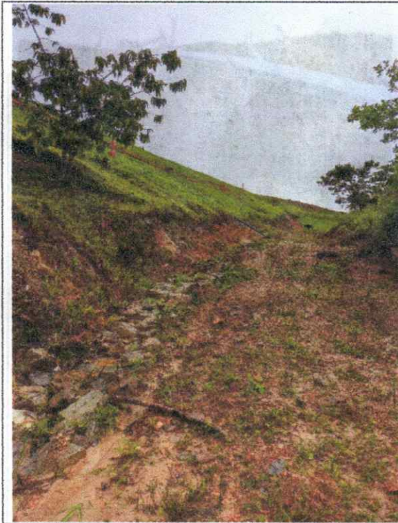
Anexo 4. Procesos erosivos en la zanja de la parte inferior del relleno
