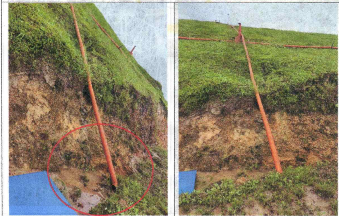
Anexo 10. Color de tubería no corresponde a su funcionalidad
