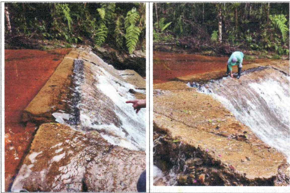
Anexo 17. Limpieza de rejilla de la bocatoma
