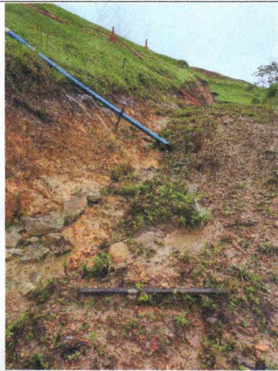
Anexo 4. Procesos erosivos en la zanja de la parte inferior del relleno
