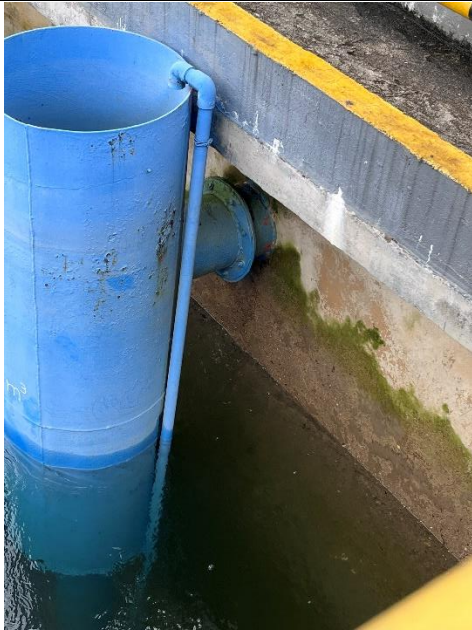
Anexo 23. Corrosión de estructuras de la planta
