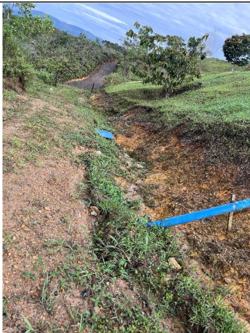
Anexo 15. Proceso erosivo en zanja de aguas lluvias.
