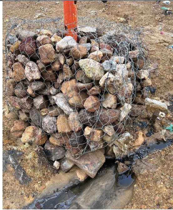
Anexo 8. Conformación de gaviones inadecuada
