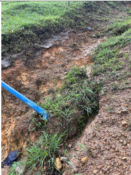
Anexo 15. Proceso erosivo en zanja de aguas lluvias.
