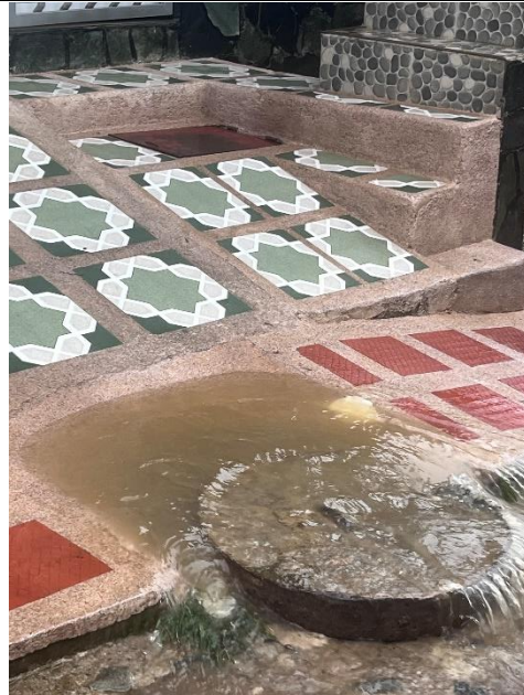
Anexo 24. Obstrucción de mh en el sector El Arenal
