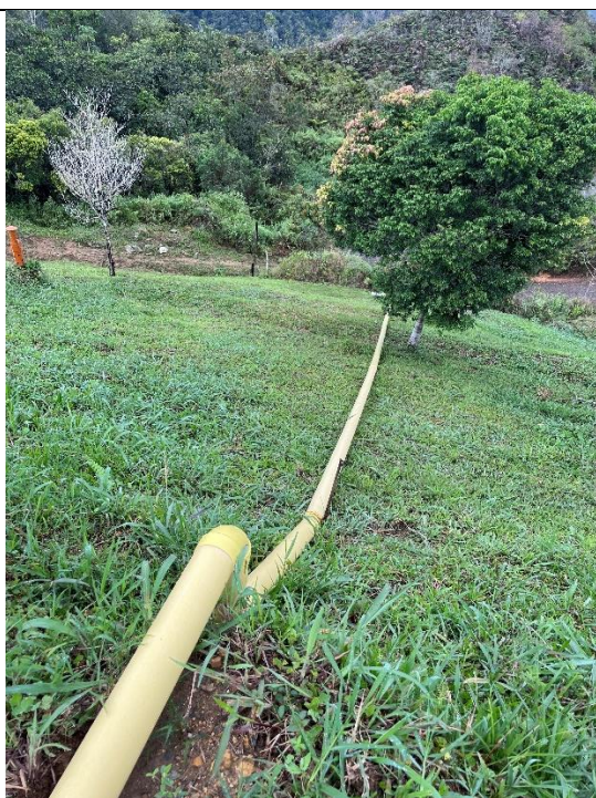
Anexo 5. Tuberías desconectadas y despintadas
